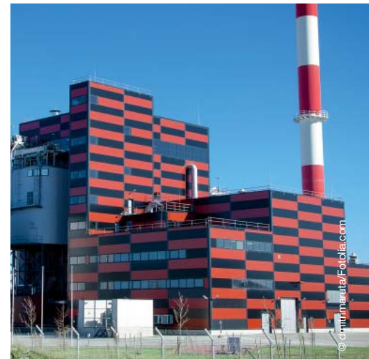
Sicherheit im Bereich Kraftwerkstechnik gewährleisten die Geräteschutzschalter 201 und 2210-T .
