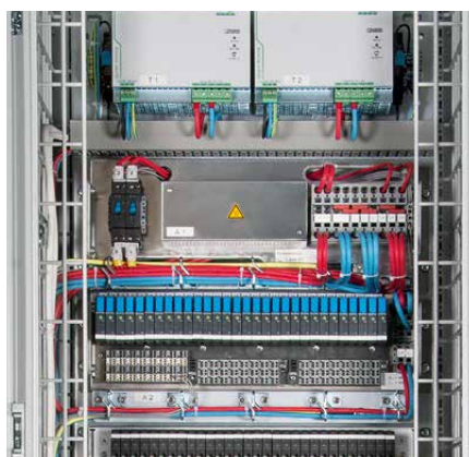
Verschiedene steckbare Sicherungselemente ESS30, ESX10-S, 8345, 2210-S, 8340, 3600
